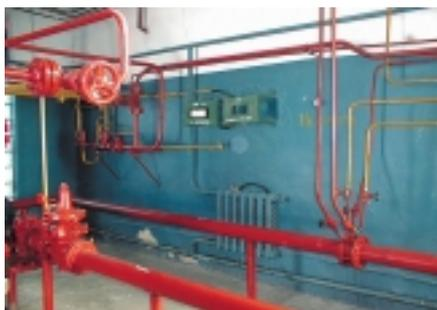
**Рис. 1. Оборудование ГРП: трубки-отводы для датчиков**
