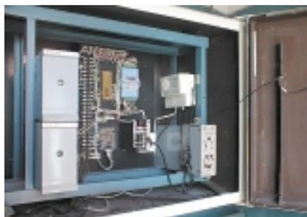
Рис. 5. Шкаф преобразователей и модуля ввода сигналов
