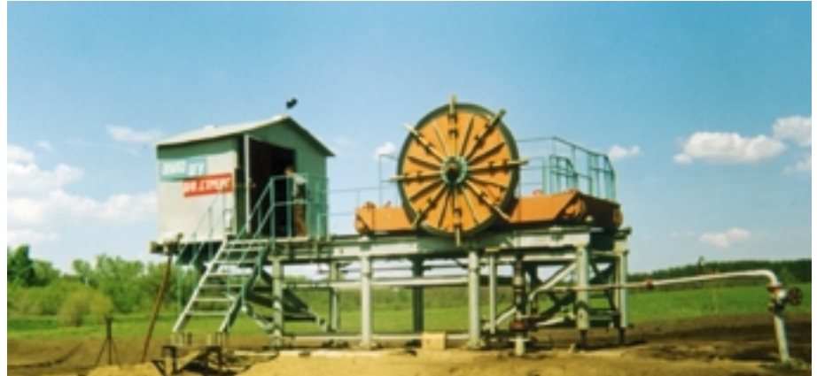
Рис. 2. Общий вид длинноходовой насосной установки
