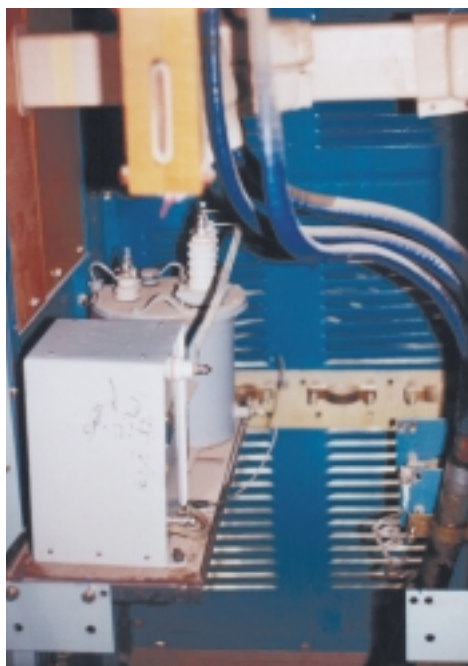
Рис. 6. Блок напряжения в ячейке шинопроводов генератора
