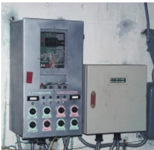
Рис. 3а. Локальная станция в цехе
