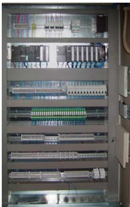
Рис. 3. Шкаф системы управления
