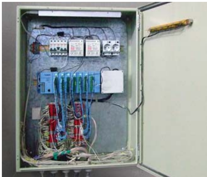
Рис. 6. Шкаф системы управления
