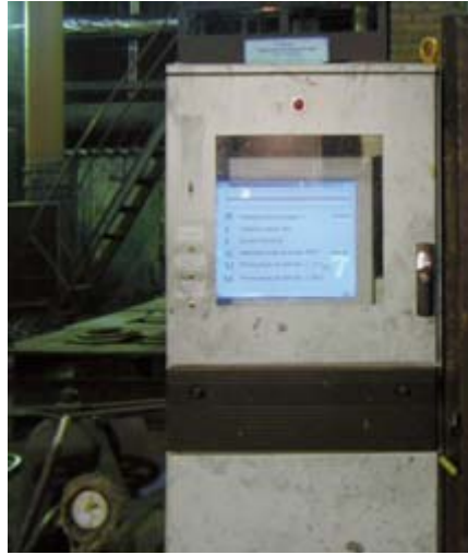
Рис. 5. Шкаф с промышленным компьютером PPC-174Т (АРМ плавильщика)
