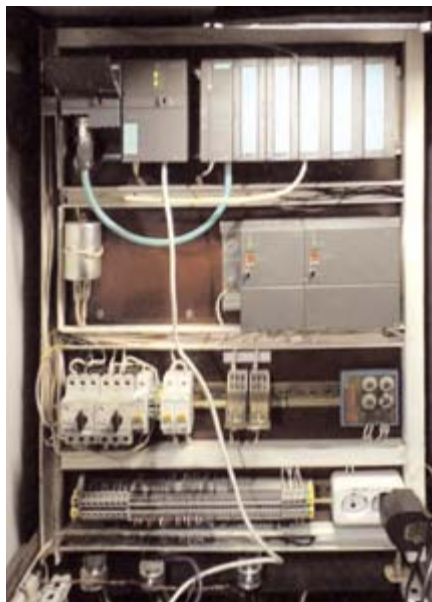
Рис. 3. Шкаф контроллера
