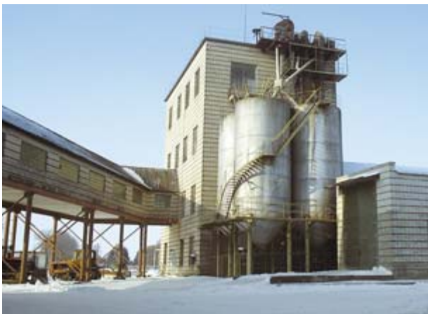
Рис. 1. Здание размольного участка ГП «Козловский спиртовой завод»
