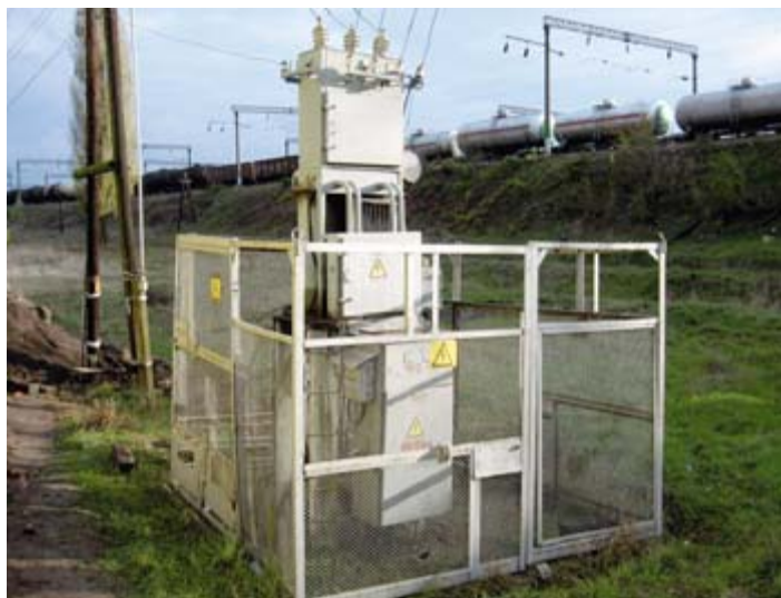
Рис. 1. Комплектная трансформаторная подстанция — энергообъект АСКУЭ ЖУ
