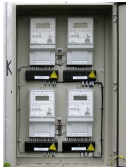
Рис. 3. Вариант установки счётчиков электрической энергии на энергообъекте
