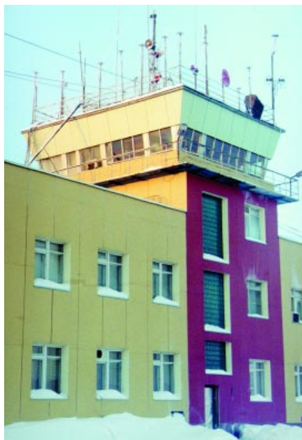
На здании командно-диспетчерского пункта аэродрома Надым установлена базовая коллинеарная антенна и спутниковые антенны для приема метеоинформации; в этом же здании располагается метеокабинет
