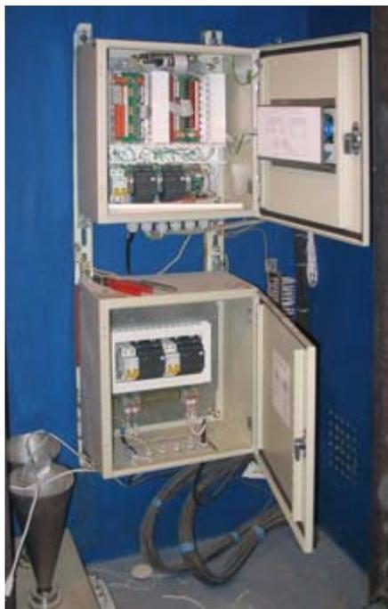
Рис. 5. Монтаж блоков Б1-БАРС 322 и БП-120
