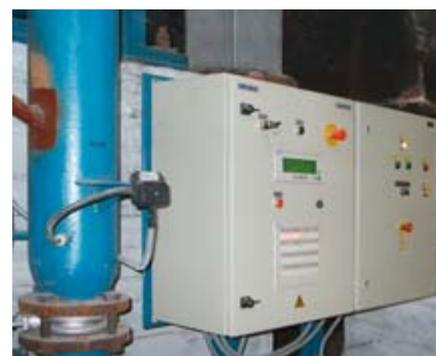
Рис. 4. Пульт управления стандом сушки и пульт управления крышкой
