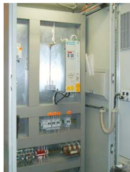
Рис. 5. Общий вид шкафа управления приводом крышки
