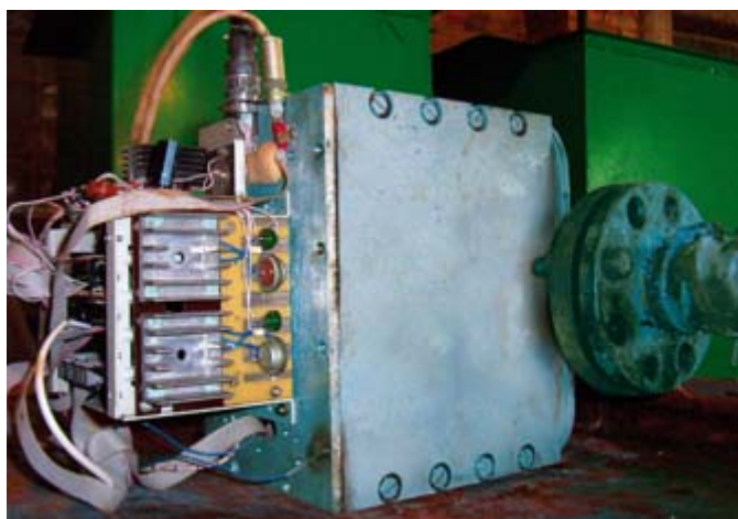
Рис. 1. Измеритель с открытой крышкой блока электроники, установленный на контролируемом трубопроводе
