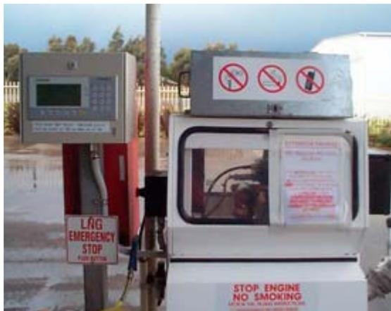
Панель TERMEХ в составе оборудования газозаправочной станции
