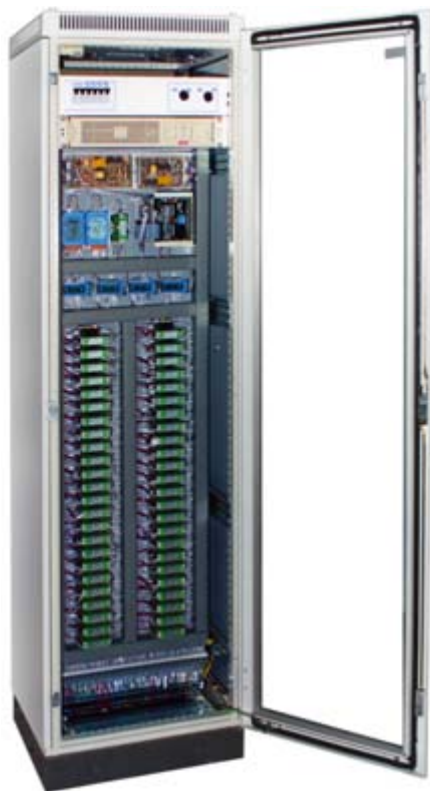
Рис. 4. Общий вид шкафа канальных адаптеров
