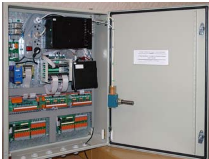
Рис. 5. Шкаф с оборудованием субкомплекса телемеханики СК-ТМ
