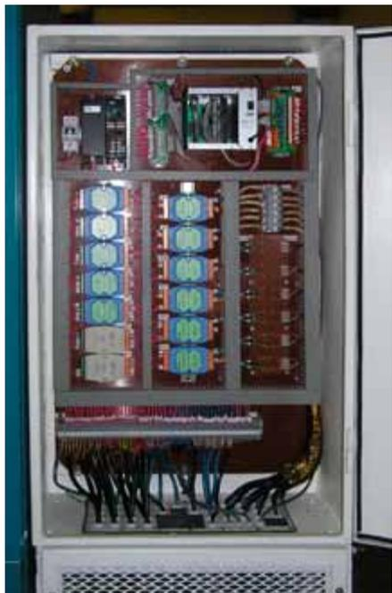
**Рис. 5. Модуль сбора информации о параметрах работы главных электроприводов непрерывной группы клетей 500**
