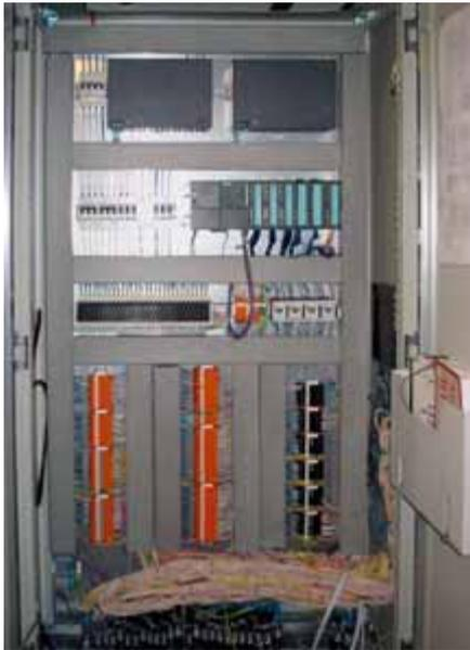
Рис. 4. Внешний вид шкафа управления тепловыми экранами
