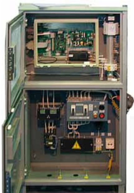
Рис. 4. Совмещённая станция управления скважиной
