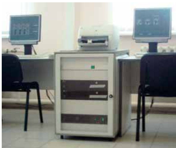
Рис. 8. Шкаф с индустриальным компьютером IPC-610, источником бесперебойного питания и выдвижной клавиатурой в помещении диспетчерского пункта
