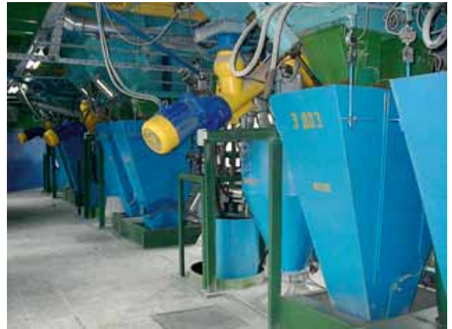
Рис. 1. Дозаторное отделение бетоносмесительного цеха
