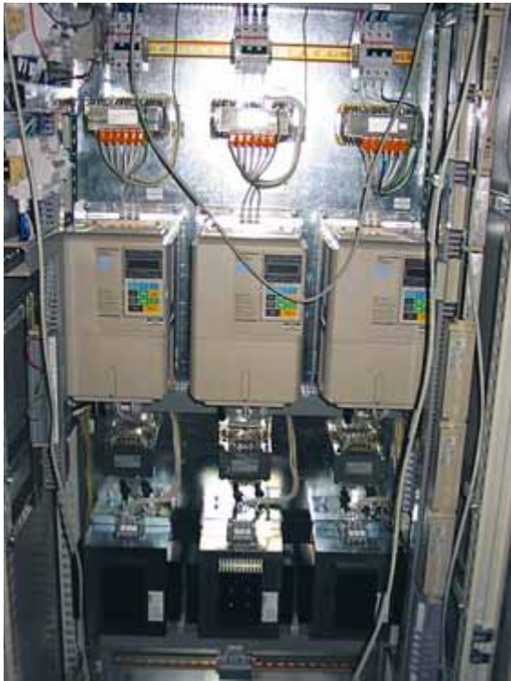
Рис. 3. Шкаф с частотными преобразователями 3G3RV-A4075-E приводов ПСУ котлоагрегата БКЗ-210
