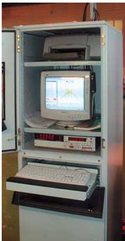
Рис. 3. Шкаф управления стенда тестирования ЭЦН
