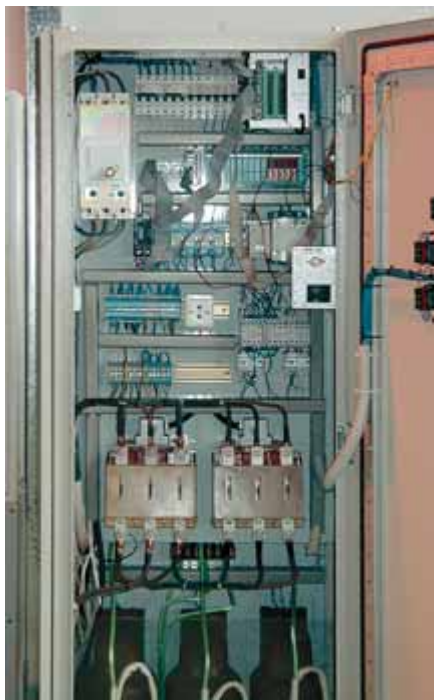
Рис. 8. Электрический шкаф с аппаратурой системы управления стандом тестирования погружного электродвигателя
