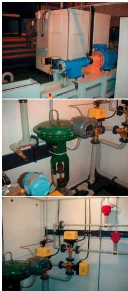
Рис. 2. Оборудование измерительного блока
