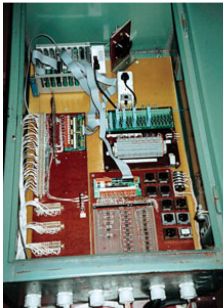
Рис. 1. Шкаф с промышленным контроллером, выполненным на основе процессорной платы Octagon Systems 5025A
