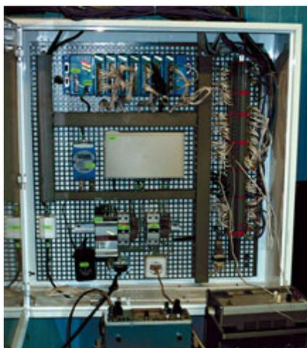
Рис. 4. Аппаратура новой системы в помещении старой операторской (момент пусконаладочных работ)
