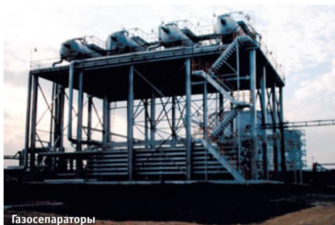
дующего отделения газообразного сероводорода в газосепараторах, а также глубокого обезвоживания и обессоливания в специальных резервуарах. Из этих резервуаров нефть через теплообменники, предназначенные для нагрева потока поступающей сырой нефти, перекачивается в ёмкости товарной нефти. В случае получения некондиционной нефти в резервуарах она для дополнительного обезвоживания подаётся к теплообменникам через электродегидраторы.
