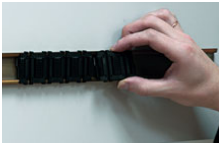
Рис. 6. Установка соединителей на рейку
