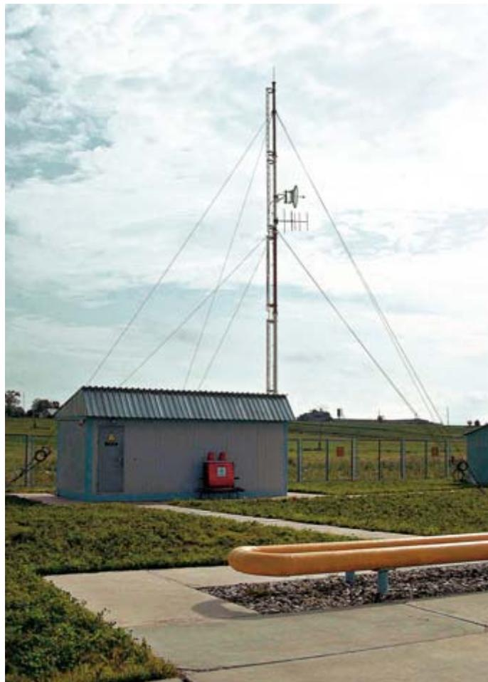
Рис. 2. Блок-бокс контролируемого пункта газораспределительной станции
