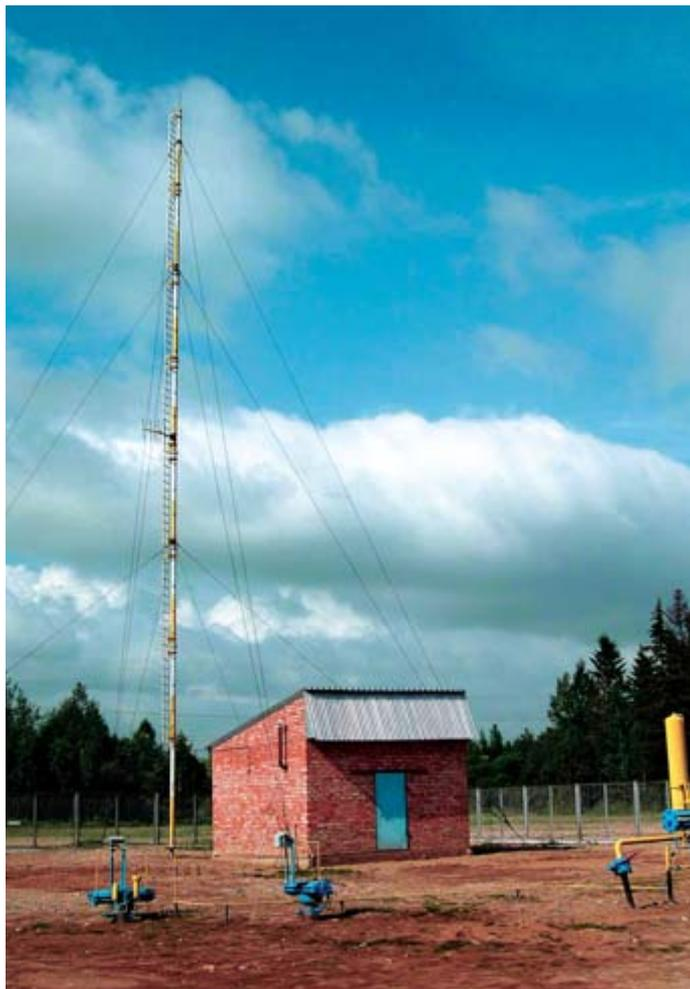
Рис. 1. Блок-бокс контролируемого пункта кранового узла
