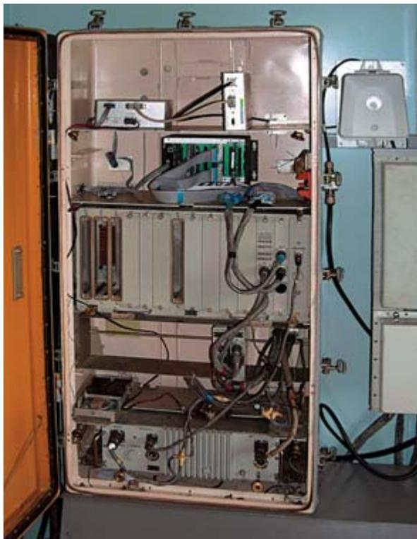
Рис. 6. Размещение УУКТ в контейнере блок-бокса контролируемого пункта системы СЛТМ-СК
