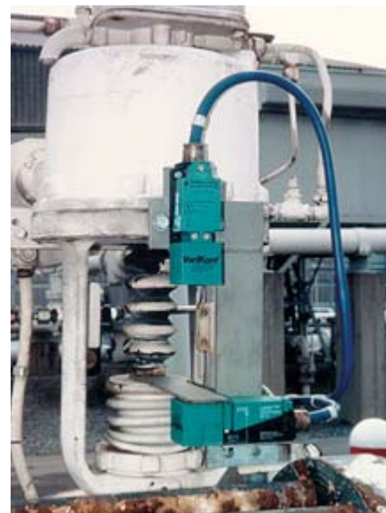
Рис. 32. Пример применения ИД в составе устройства управления приводом
