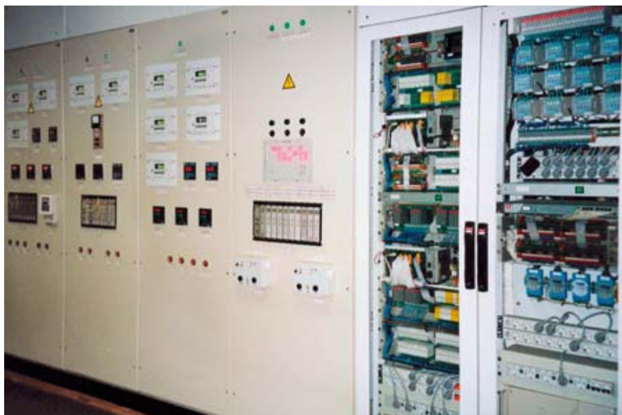
Рис. 4. Стойки контроллеров MicroPC и щитов КИП и А
