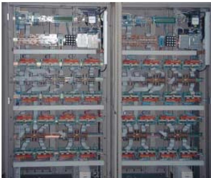
Рис. 3. Шкафы подсистемы ввода дискретных сигналов (ПВДС)
