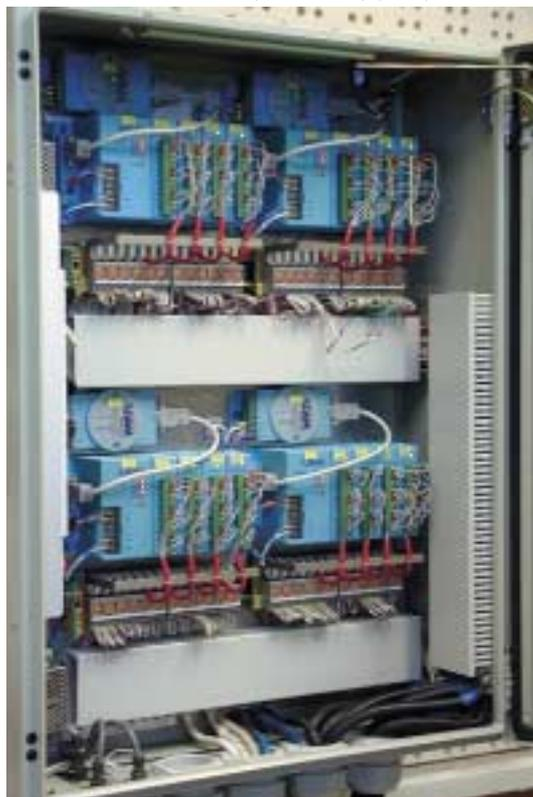
Рис. 5. Один из шкафов с оборудованием подсистемы ввода сигналов от датчиков температуры (ПВСДТ)
