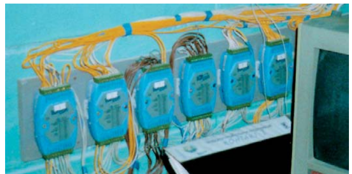
Рис. 4. Интерфейсный модуль и модули аналогового ввода серии RIO-7000
