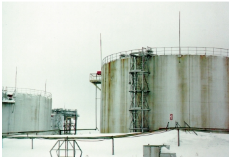
Рис. 1. Общий вид резервуарного парка
