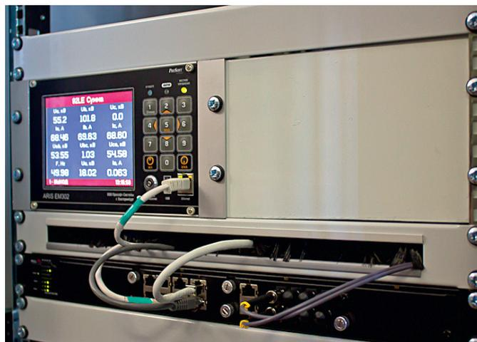
Рис. 2. ARIS EM302 с интерфейсом МЭК 61850-9-2LE на подстанции «Магистральная» 220 кВ
