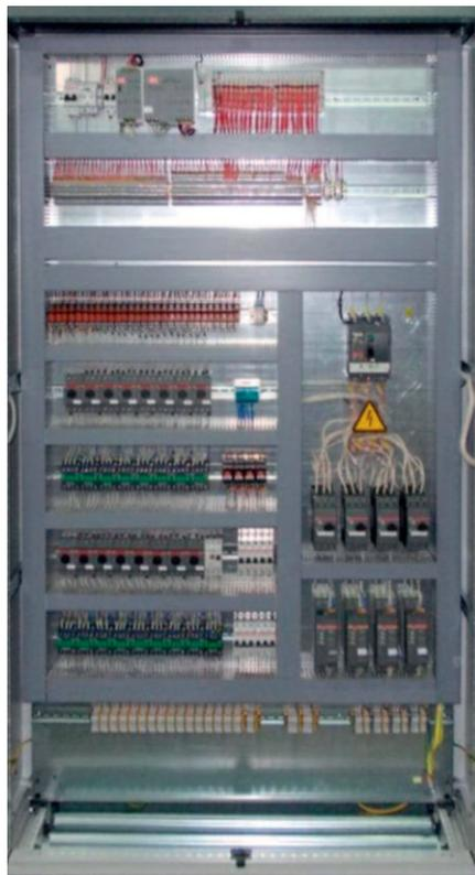
Рис. 4. Размещение оборудования в шкафу контроллера БСУ
