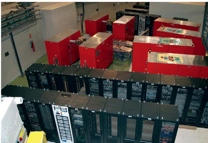
Рис. 3. Несколько сотен шкафов Varistar вмещают основное оборудование контроля и управления
