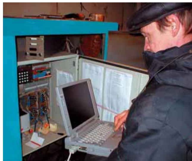
Рис. 3. Периферийное устройство регистрации с открытой крышкой шкафа
