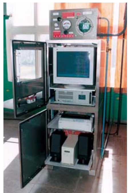
Рис. 5. Размещение вычислительного оборудования во взрывозащитном шкафу
